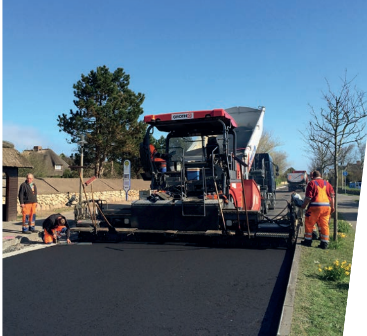
Mit einem Spezialfahrzeug wurde der neue Asphalt millimetergenau verlegt FOTO: BOYSEN
